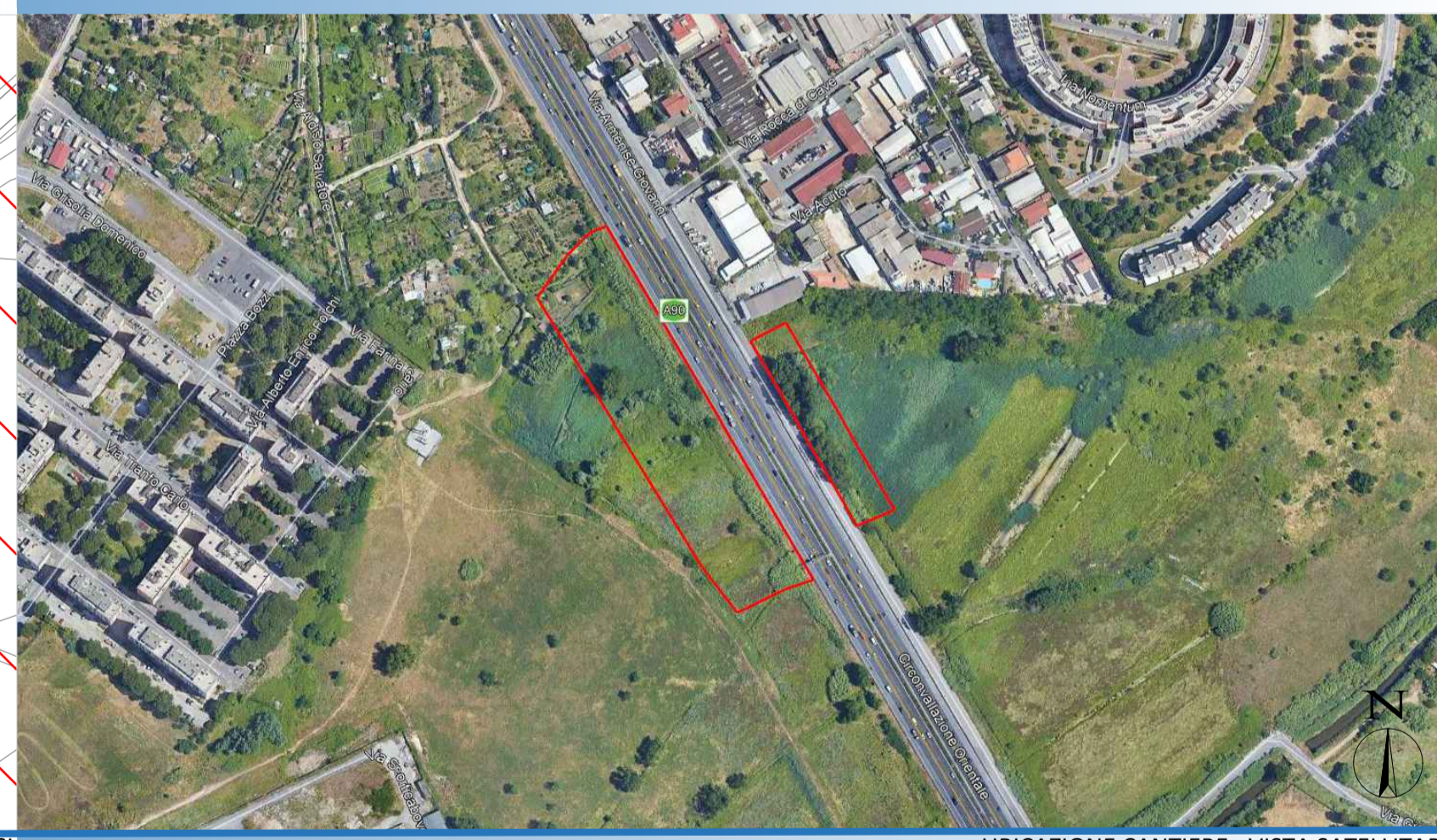
UBICAZIONE CANTIERE - VISTA SATELLITARE
