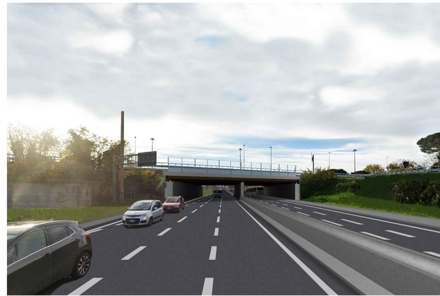
STATO POST OPERAM
