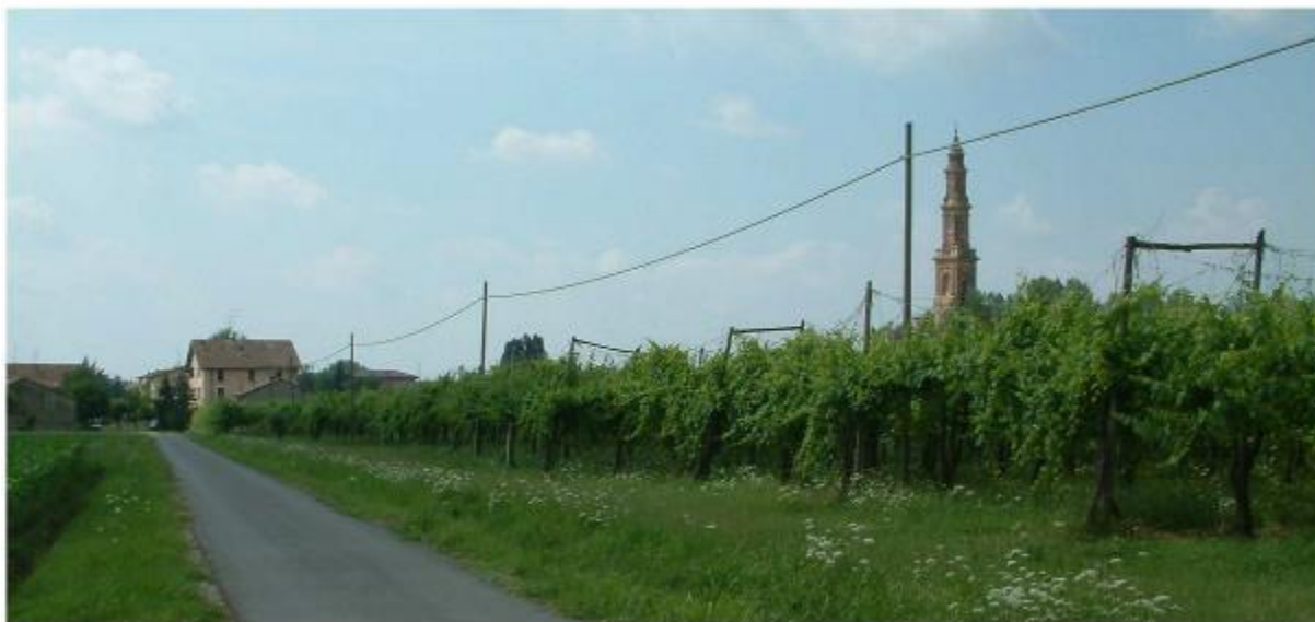
Figura 9 – Scorcio del campanile di villa Sesso, visto da via U. Bassi in prossimità dell'incrocio con via Salimbene da Parma, proprio dove secondo il progetto di Terna arriverebbe la tratta RE1 dell'elettrodotto (estratto della Relazione Opportunità di Paesaggio Allegato P8.1 al PSC Comunale di Reggio Emilia, pag. 6).
