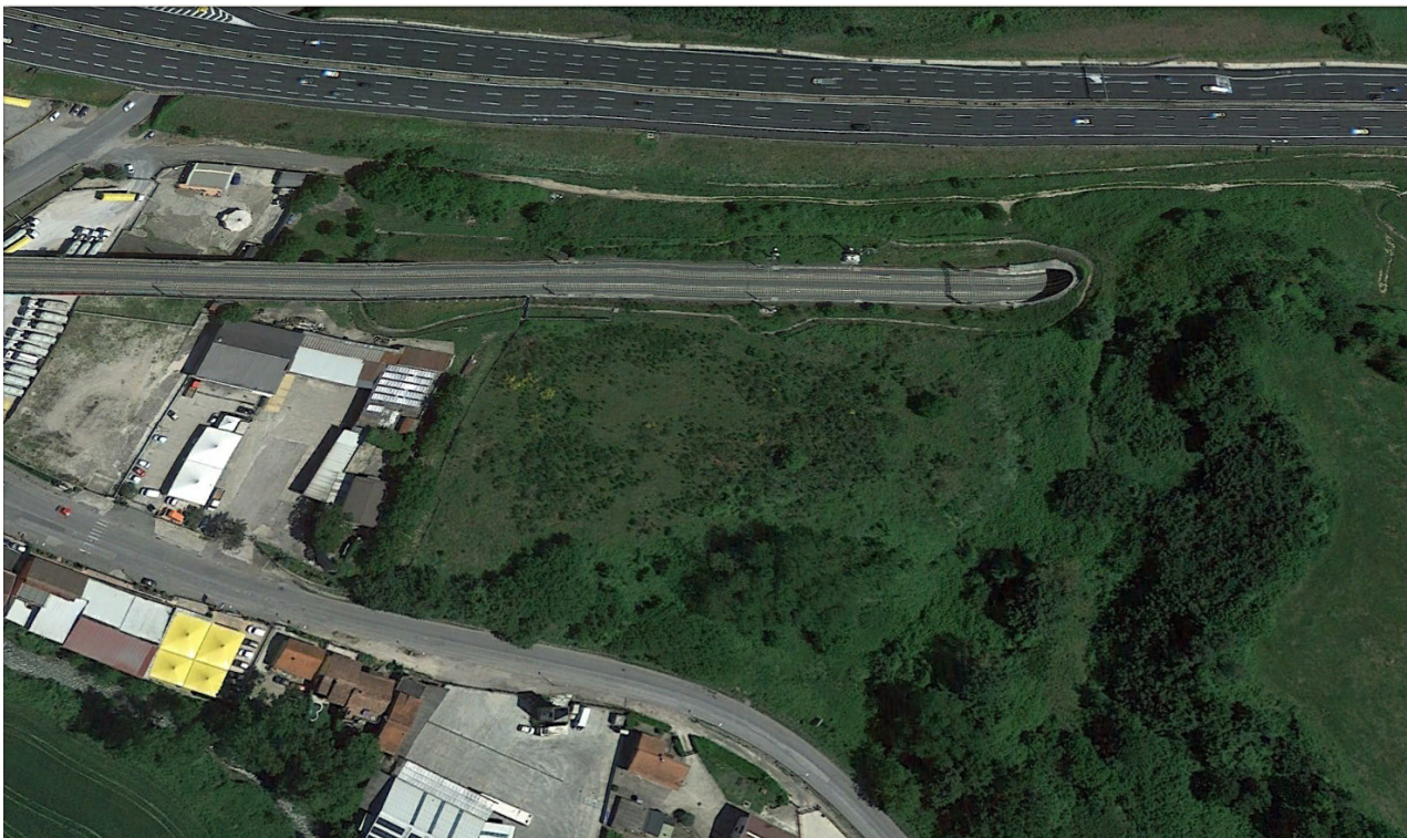
Galleria Castello Imbocco Nord – Ante Operam
