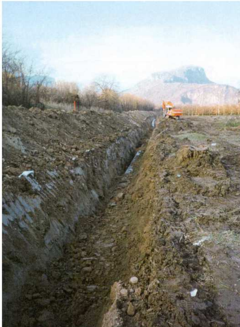
Figura 3-18 –Rinterro condotta
