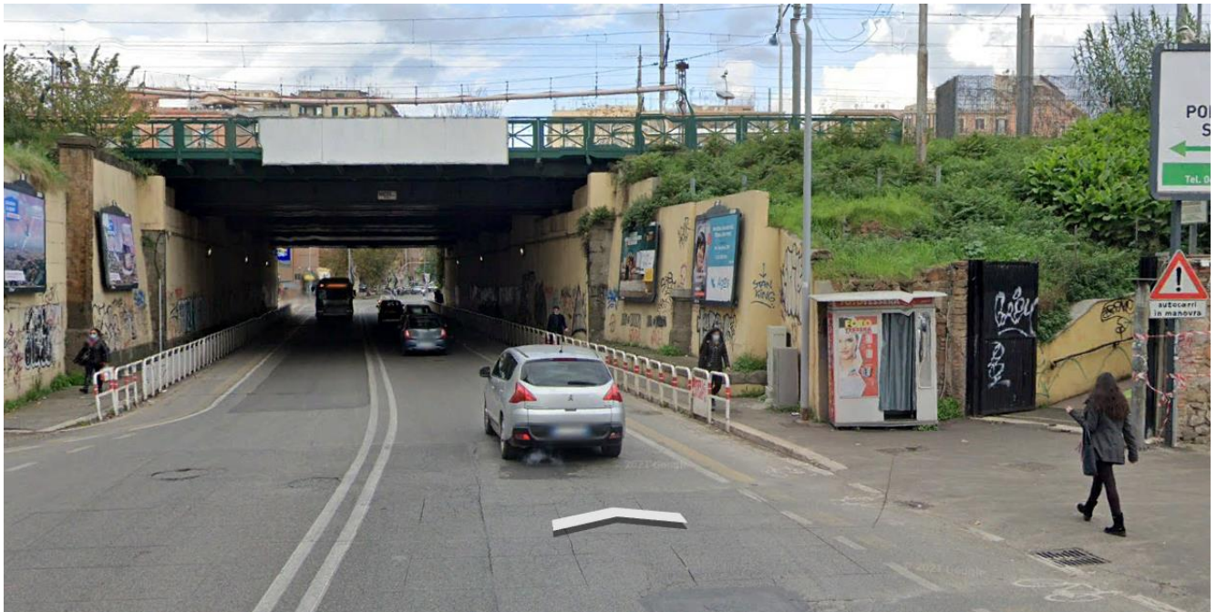
Foto sottopassaggio di via Tuscolana (marciapiede Dx da chiudere temporaneamente)
