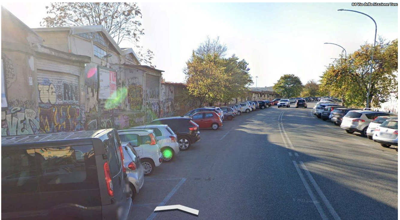
Foto di via della Stazione Tuscolana (fabbricati in demolizione)
