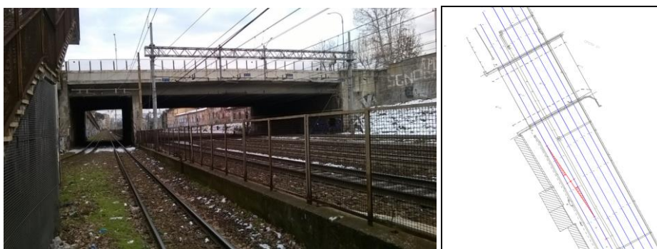
Cavalcaferrovia Piazza del Pigneto (in blu i binari esistenti ed in rosso quelli di progetto)
