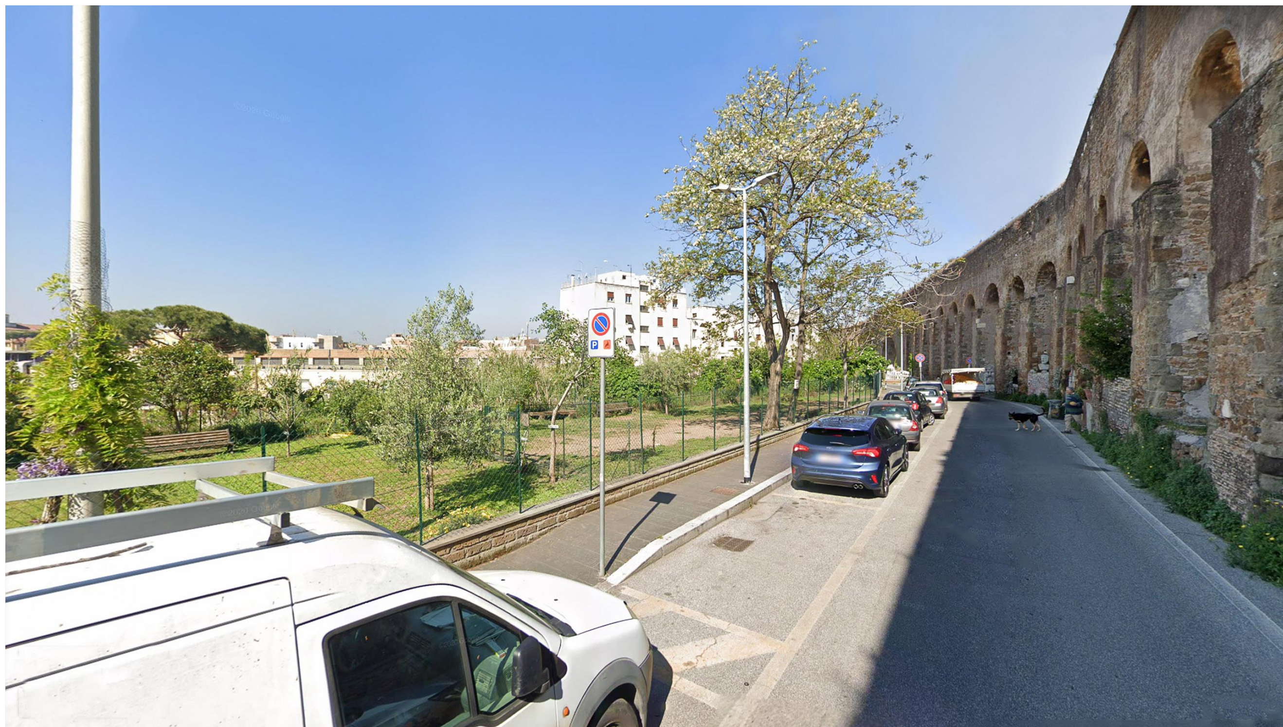
F01 VIA CASILINA VECCHIA ANTE OPERAM
