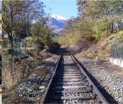
Impianto lubrificazione P.A.L. Italia (Foto: P.A.L. Italia; 2012)
