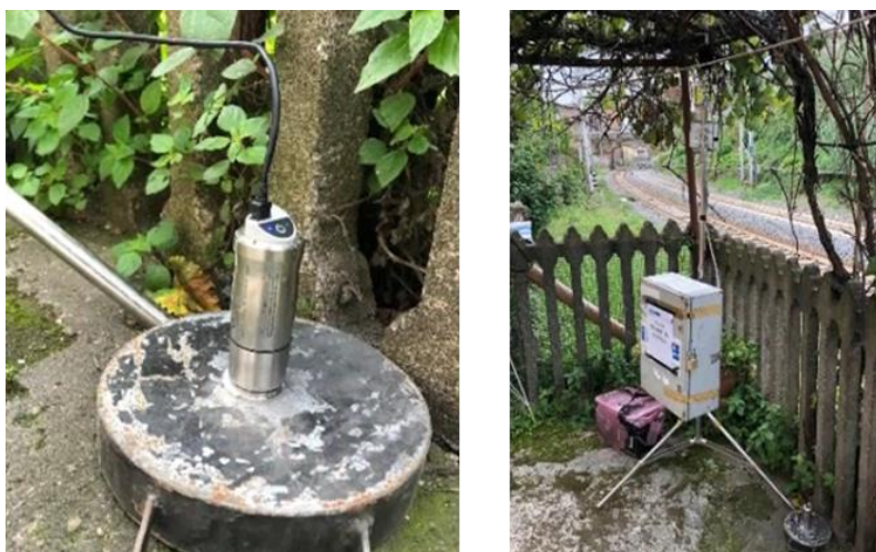
Figura 3-3 Esempio di installazione dell'accelerometro (cfr. elaborato NR4500D22RHIM0004003A)
