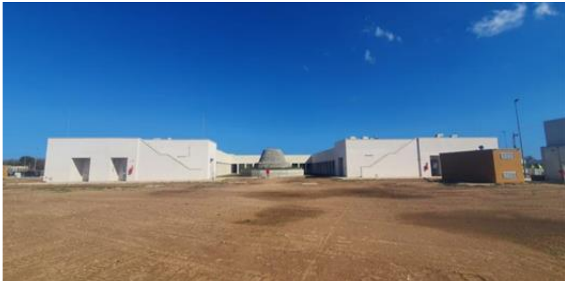
Figura 8: ricollocamento Top-Soil nel cantiere del PRT
