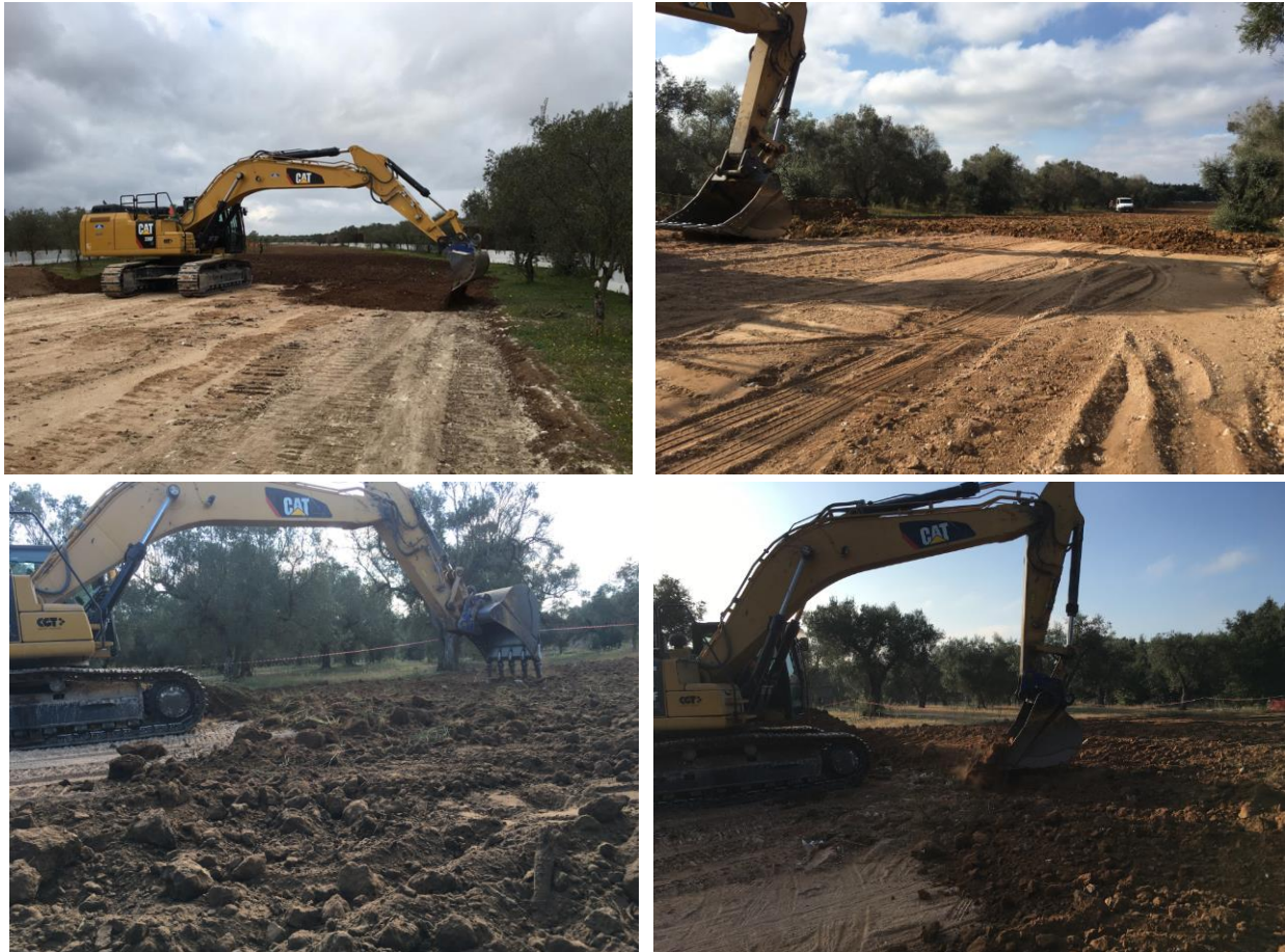
Figura 11: Posa dello strato superficiale di Top Soil con esecuzione del ripristino “a ritroso”
