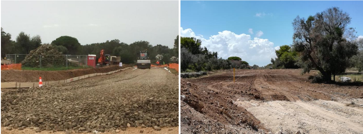
Figura 2: Realizzazione strada di accesso e Ricollocamento del Top-Soil
