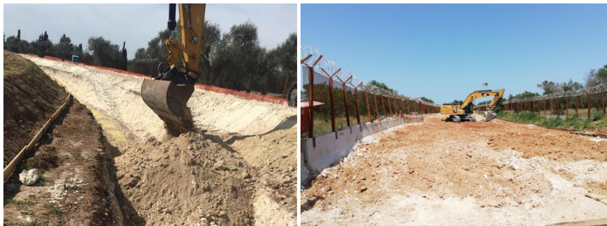
Figura 10: Rinterro della trincea con lo stesso materiale proveniente dallo scavo della trincea
