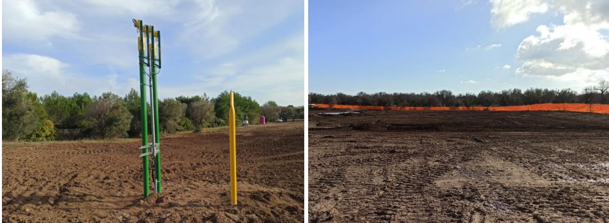
Figura 5: Area cantiere microtunnel dopo il ricollocamento del Top Soil
