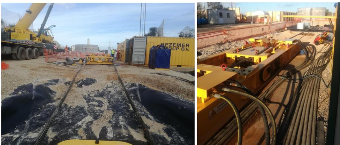
*Figura 12: Attrezzatura per l'attività di tiro della condotta su area impermeabilizzata*
