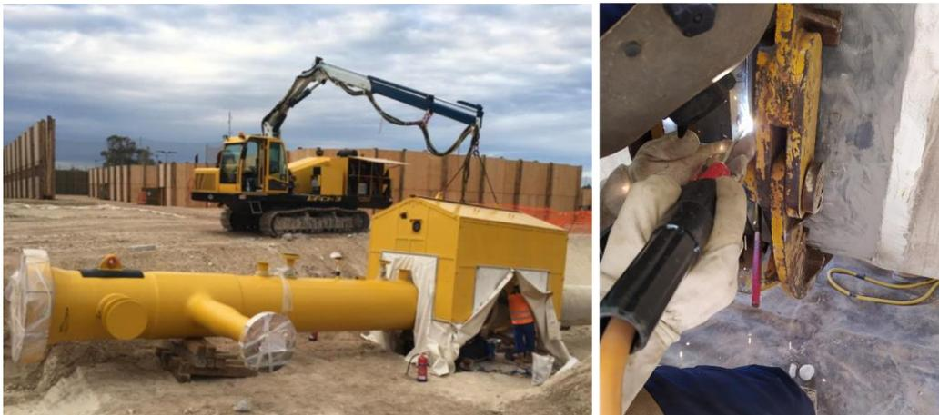
Figura 9: Saldatura del piatto di prova con la condotta offshore per collaudo idraulico
