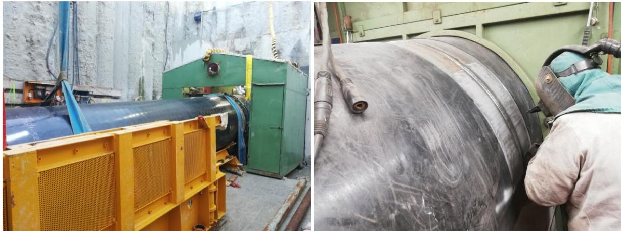
*Figura 10: Saldatura tubo di protezione da 56" per la realizzazione del casing pipe*
