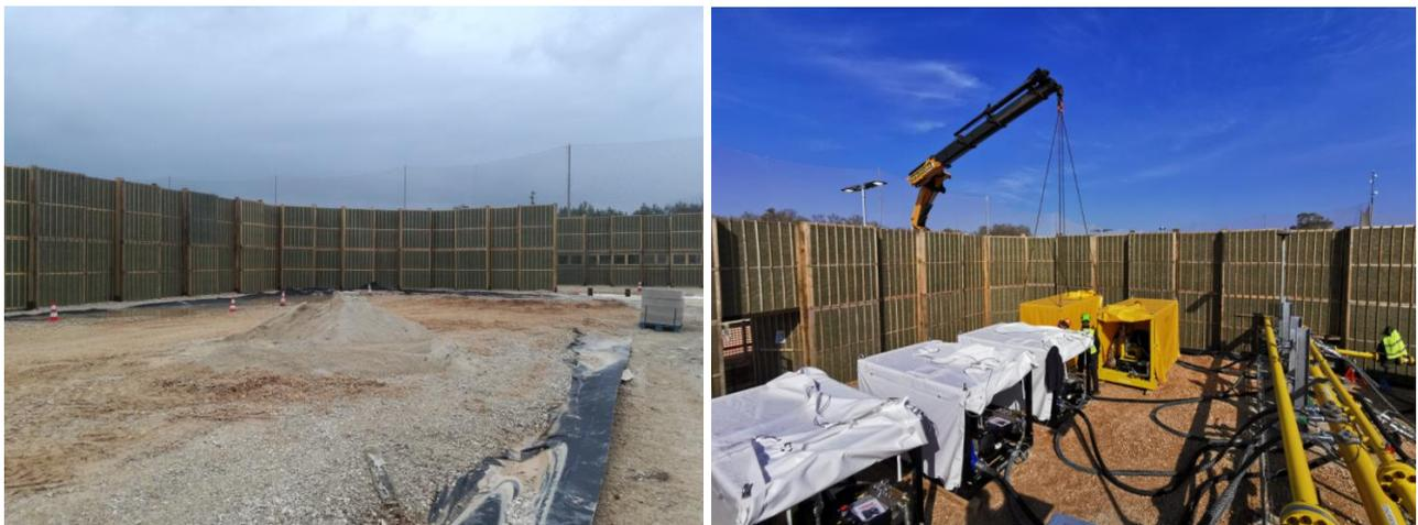
*Figura 11: Attrezzature per attività di collaudo idraulico su aree impermeabilizzate*
