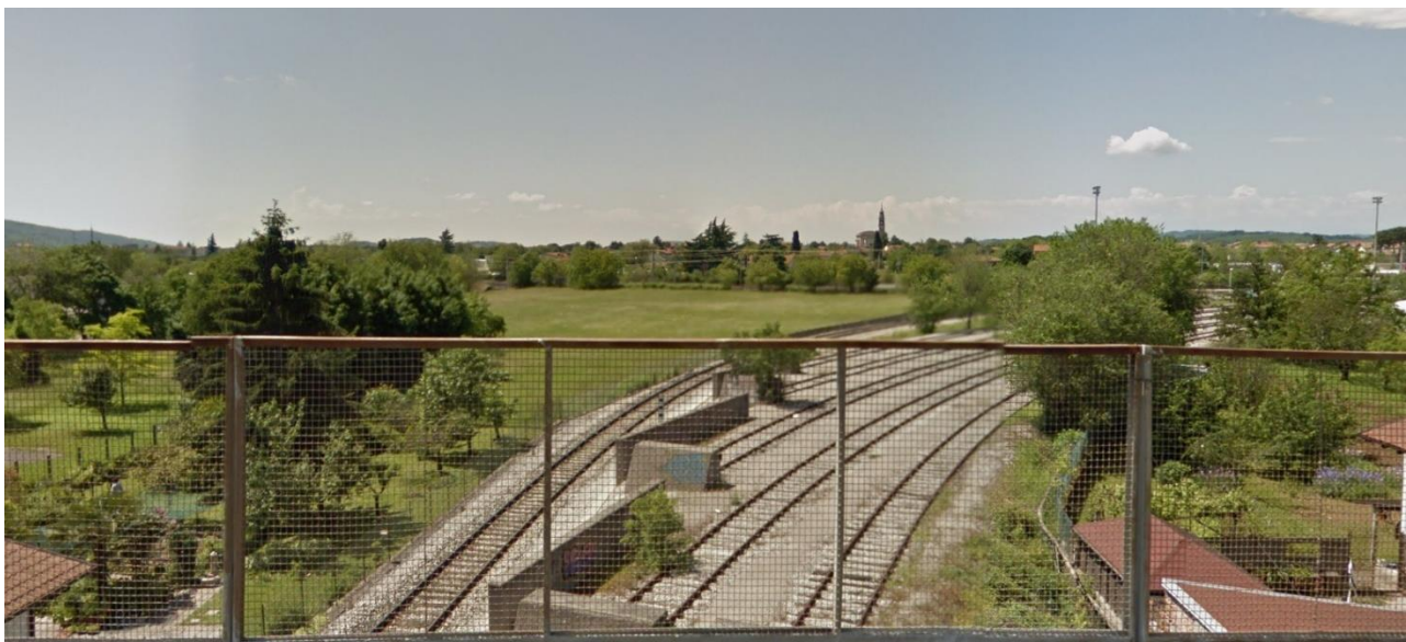
Figura 4-34 Vista dal ponte di Via Trieste in direzione della ferrovia. In corrispondenza dell'area prativa al centro dell'immagine è previsto il nuovo binario di progetto.
