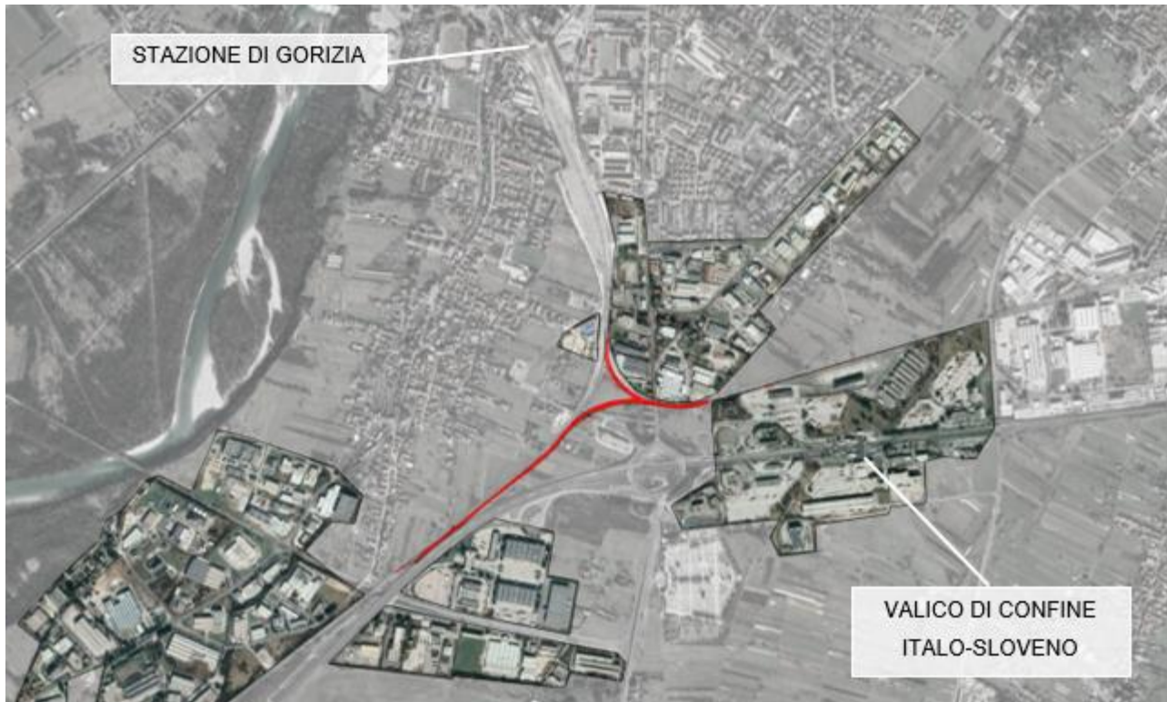
Figura 4-30 Comparti industriali in prossimità del tracciato di intervento. (Fonte Google Maps).
