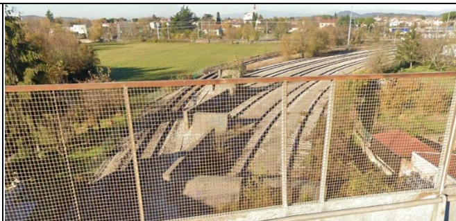
Foto 7ovest: Vista da via Trieste, (in direzione ovest) sul cavalcaferrovia che attraversa la linea ferroviaria oggetto d'intervento.
