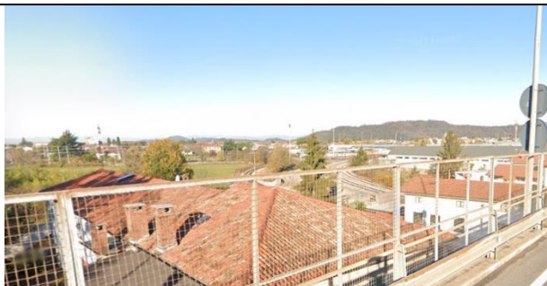
Foto 6: Vista da via Trieste in direzione della futura "lunetta" (sulla sinistra) e del lato Gorizia (sulla destra)
