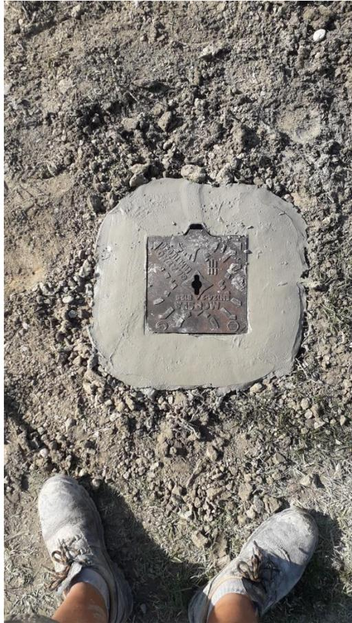
*Figura 18 – Pozzetto carrabile a protezione della strumentazione installa nel sondaggio
