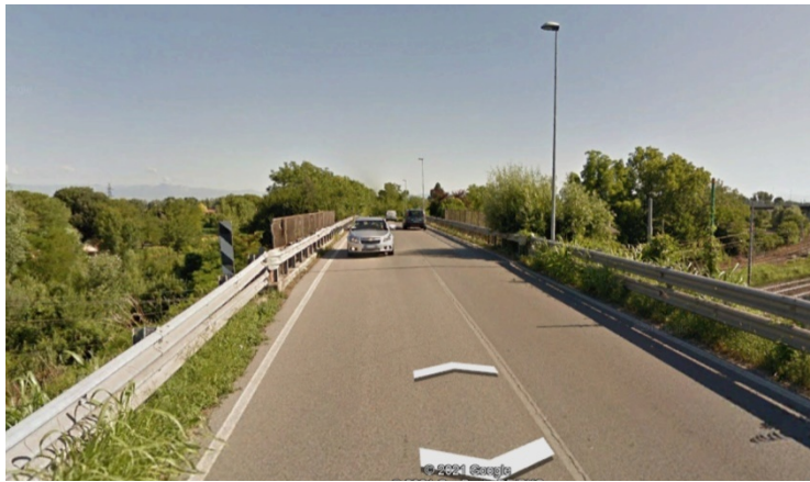
Vista della carreggiata della SP463
