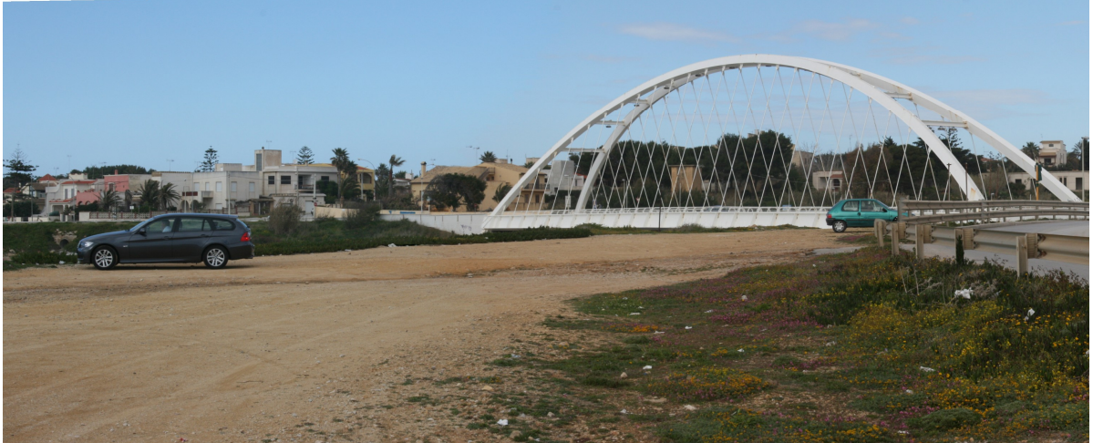
Figura B 13-1 Punto di approdo del cavidotto marino in località La Bocca , Comune di Mazara del Vallo (TP)
