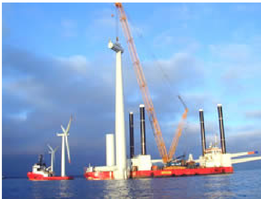
Figura B 7-3 Pontone durante l'assemblaggio di una navicella – [ http://www.c-power.be ]
