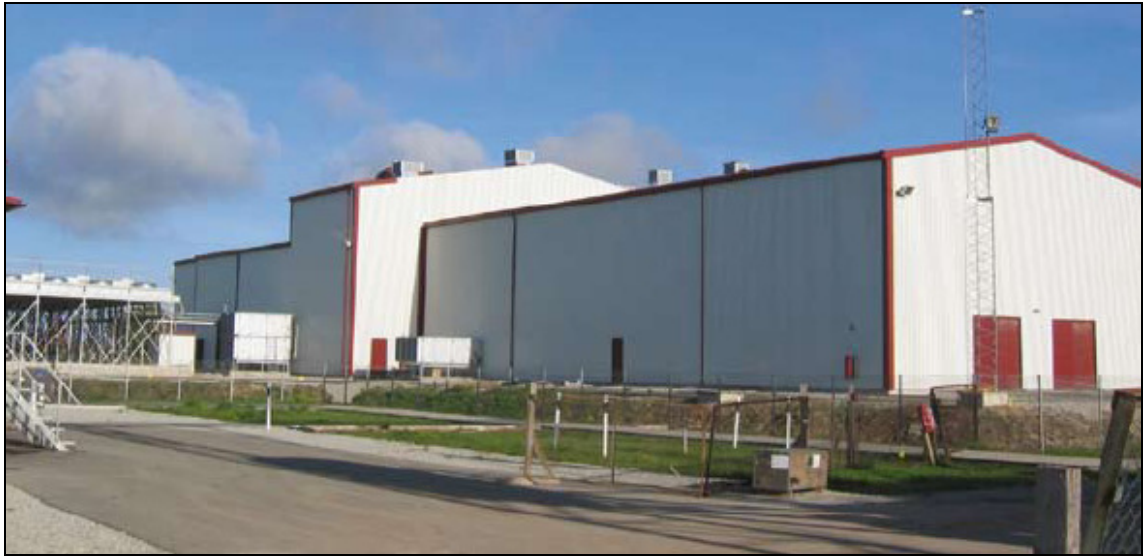
Figura B 15-2 ESP ABB HVDC Light da 350 MVA installata ad Harku, Estonia
