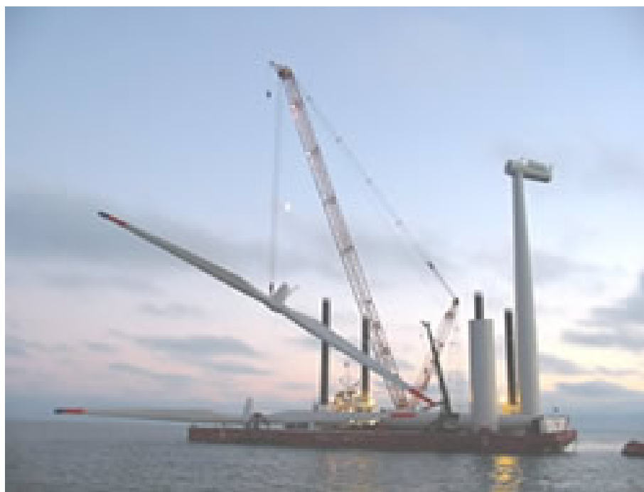
Figura B 7-5 Pontone durante il montaggio di un rotore con le pale preassemblate - [ http://www.c-power.be ]
