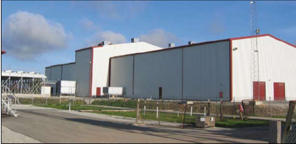
Figura C 7-1 ESP ABB HVDC Light da 350 MVA installata ad Harku, Estonia.
