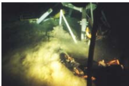
Figura C 4-6 Lancia idraulica in uno scavo sottomarino.
