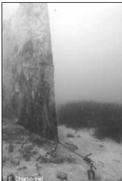
Figura C 4-3 Uno schermo in geotessile (a sinistra) che protegge una prateria di Posidonia oceanica (a destra) in un lavoro sottomarino in Francia. (foto E. Charbonnel)
