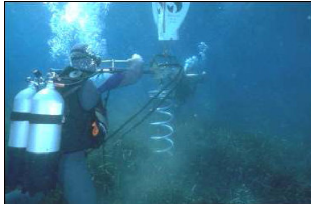
Figura C 4-9 Avvolgimento dell'elicoidale d'acciaio speciale Harmony® Tipo P: ancoraggio senza alterazione della prateria a Posidonia oceanica .
