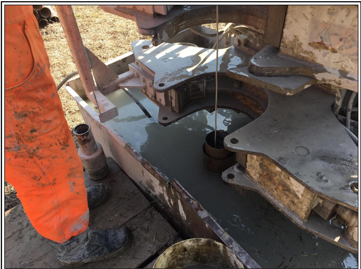
**Sondaggio PM1-Rilievo masse metalliche in foro**
