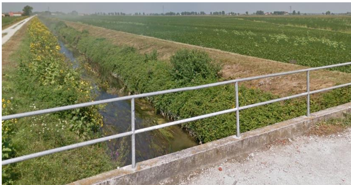
Figura 5-2 Vegetazione acquatica presente lungo i canali del Reghene altezza della pK 67+ 420,39 del tracciato di PdM Fossalta (Da Google Maps)
