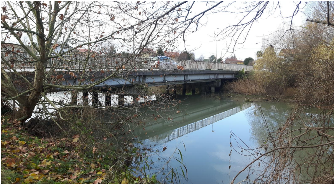
Figura 7. Fiume Lemene: ponte stradale di via San Martino.
