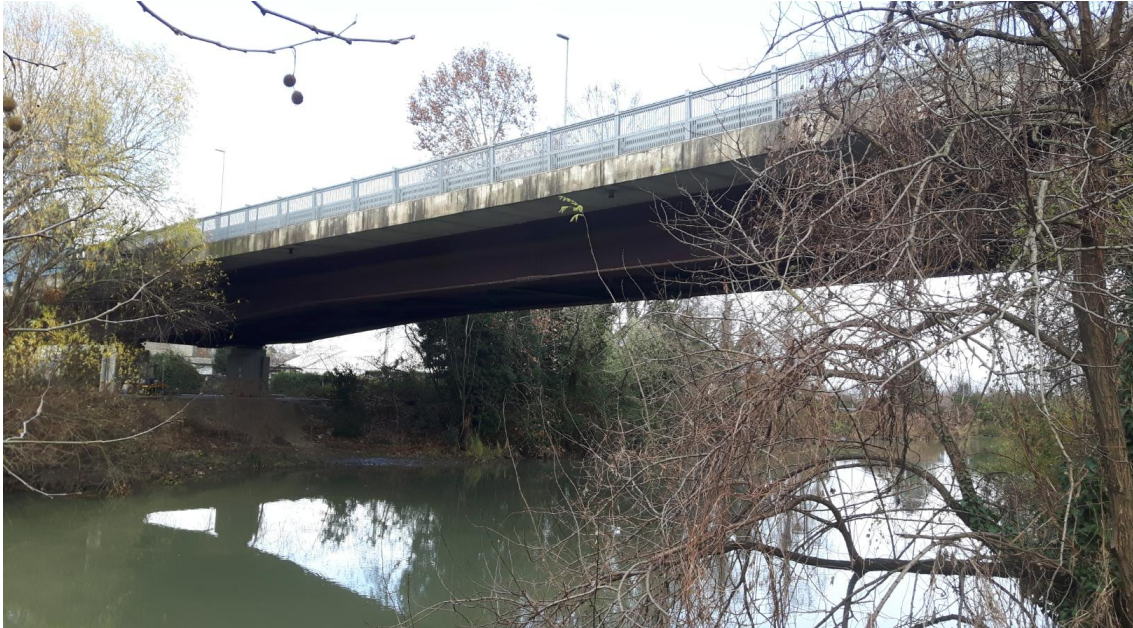
Figura 6. Fiume Lemene: ponte della strada SS14.
