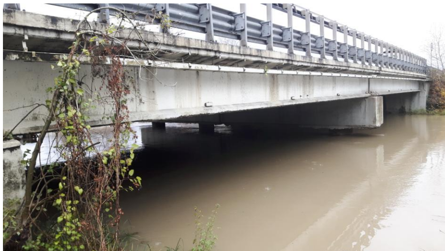
Figura 5. Fiume Lemene: ponte dell'Autostrada A4 Torino-Trieste.
