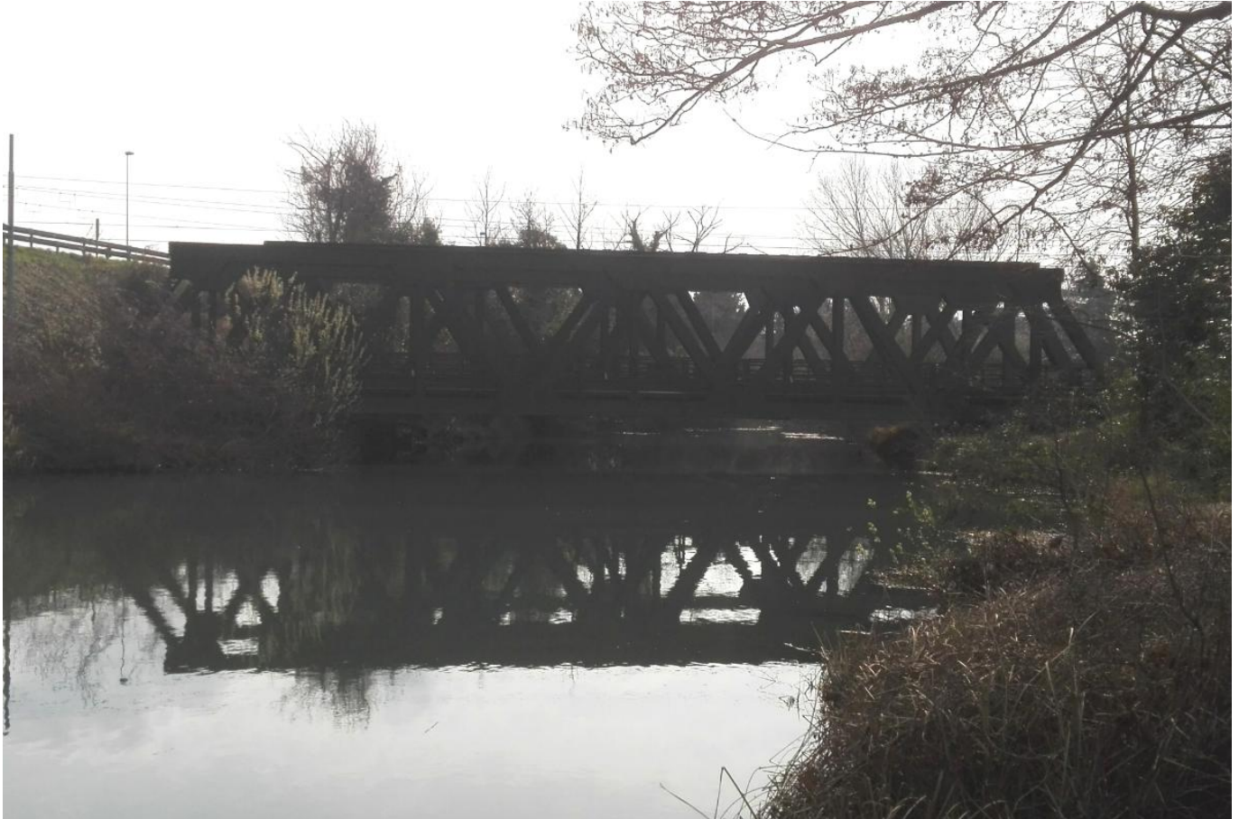
Figura 8. Fiume Lemene: ponte ferroviario esistente della linea Venezia-Trieste.
