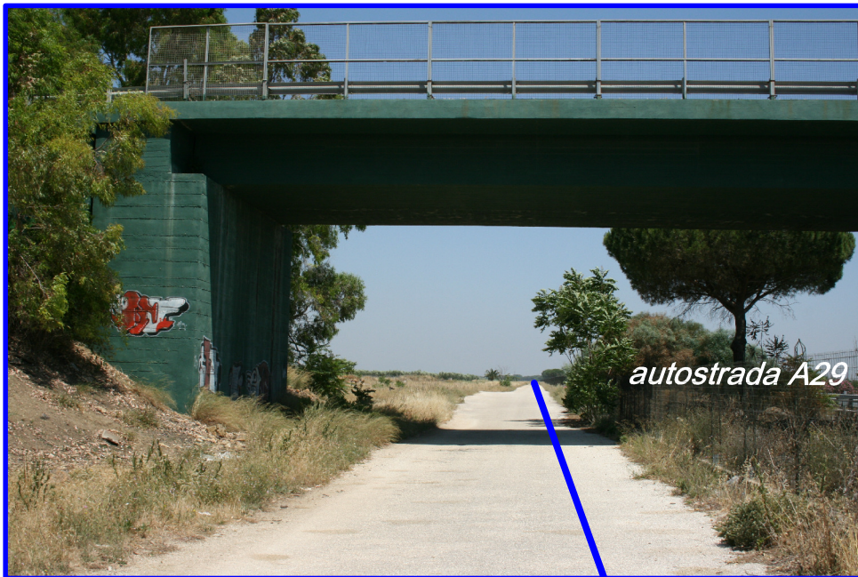
FOTO 15 - strada parallela all'Autostrada A29 in corrispondenza dello "svincolo di Saporito"
