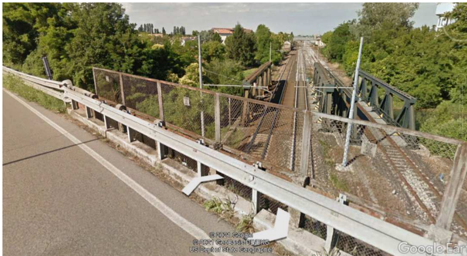
Vista degli elementi attualmente presenti a margine della carreggiata della SP463
