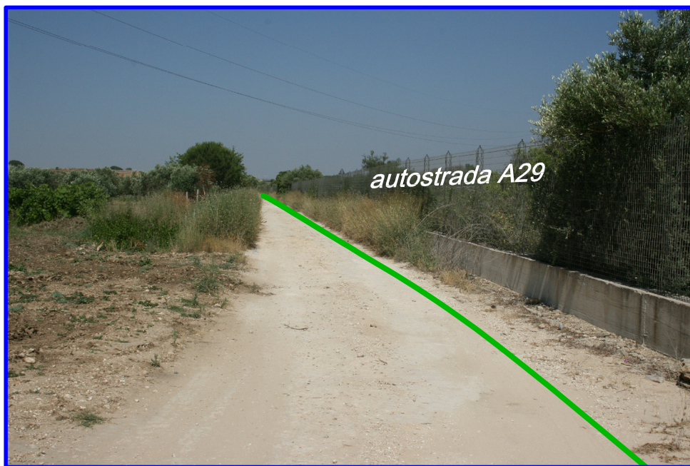
FOTO 23 - posa su strada sterrata parallela all'autostrada A29 Palermo-Mazara del Vallo
