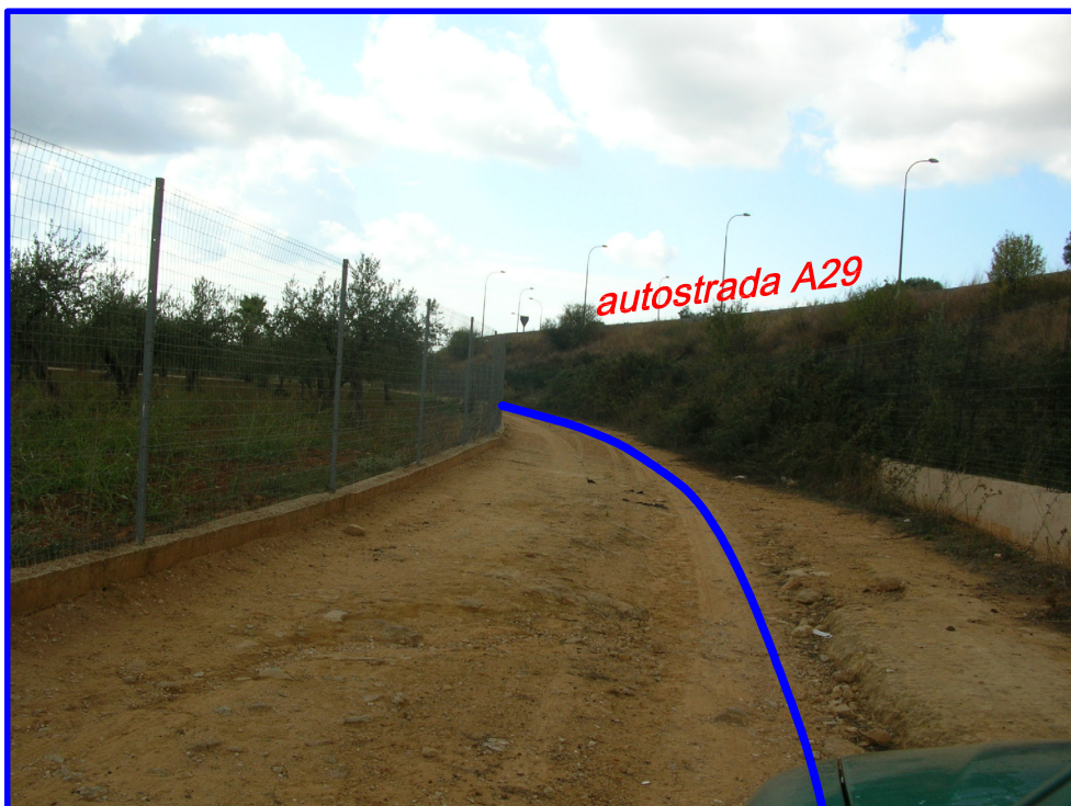
FOTO 30 - posa su strada sterrata parallela all'autostrada A29 Palermo-Mazara del Vallo
