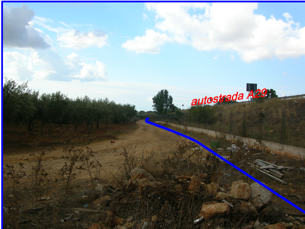
FOTO 31 - posa su strada sterrata parallela all'autostrada A29 Palermo-Mazara del Vallo
