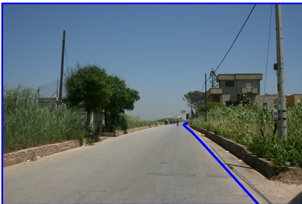
FOTO 3 - via California - Comune di Mazara del Vallo (TP)
