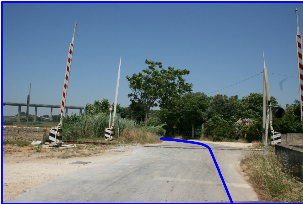
FOTO 9 - attraversamento della linea ferroviaria Palermo - Trapani via Castelvetrano
