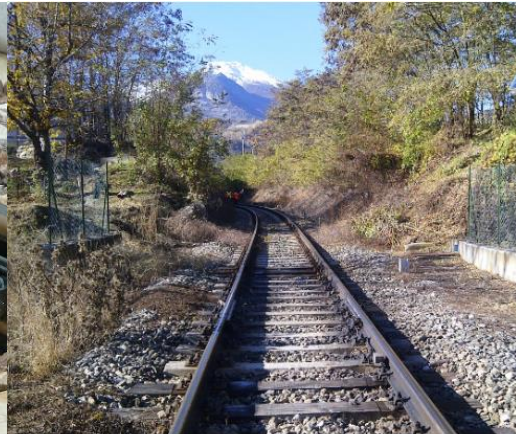
Impianto lubrificazione P.A.L. Italia (Foto: P.A.L. Italia; 2012)
