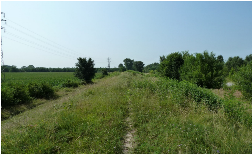
Argine artificiale in sponda orientale del Fiume Isonzo
