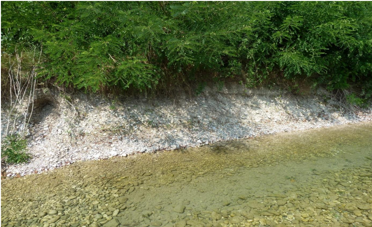
Figura 25 – Dettaglio della scarpata fluviale in sponda destra del Fiume Isonzo, impostata sui terreni ghiaioso-sabbiosi dei Depositi alluvionali attuali (ba1), ripresa da E.
