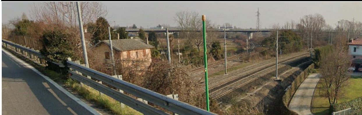
Figura 4-24 Sistema infrastrutturale nell'ambito di Portogruaro: linea ferroviaria esistente in corrispondenza di SP 463 (Fonte: Google Earth)
