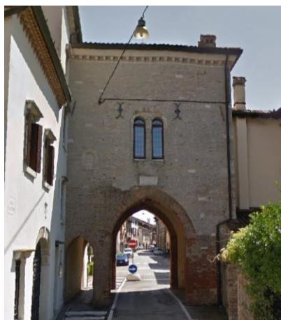
Figura 4-40 Beni culturali nell'ambito di Portogruaro: Porta San Gottardo (Fonte: Google Earth)
