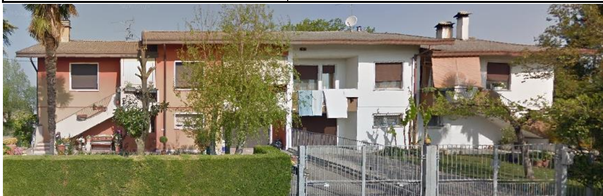
Figure 4-29 Sistema insediativo nell'ambito di San Donà di Piave: tessuto di tipo residenziale in Via delle Statue (Fonte: Google Earth)
