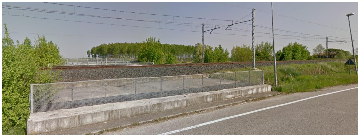
Figura 4-23 Sistema infrastrutturale nell'ambito di San Donà di Piave: linea ferroviaria esistente in corrispondenza di Via del Silos (Fonte: Google Earth)
