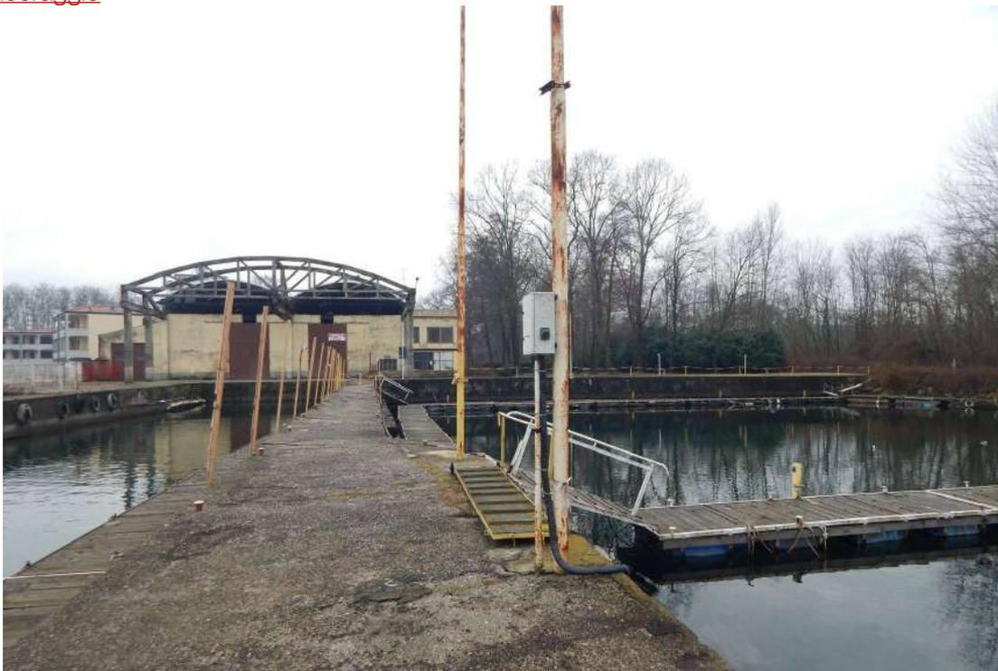
*Figura 17: Pontile in cemento con pali di ormeggio - stato ante operam*
