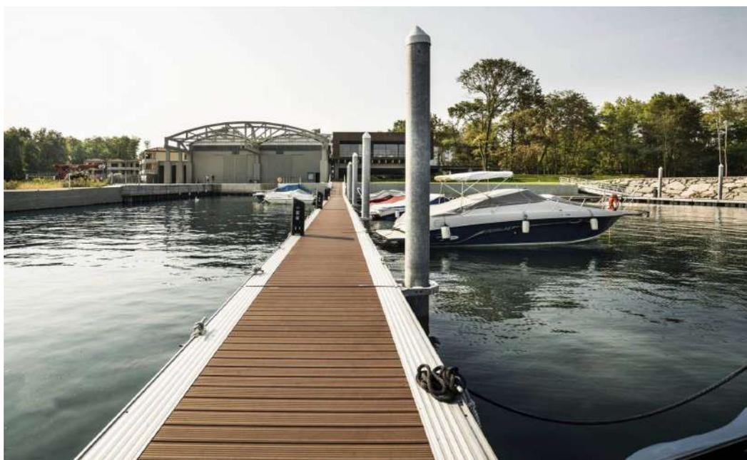
*Figura 18: Pontile con pali di ormeggio - stato post operam (il pontile in cemento è stato sostituito da un pontile galleggiante)*
