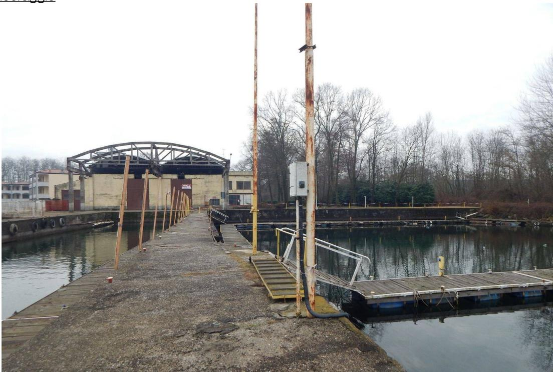
*Figura 7: Pontile in cemento con pali di ormeggio - stato ante operam*
