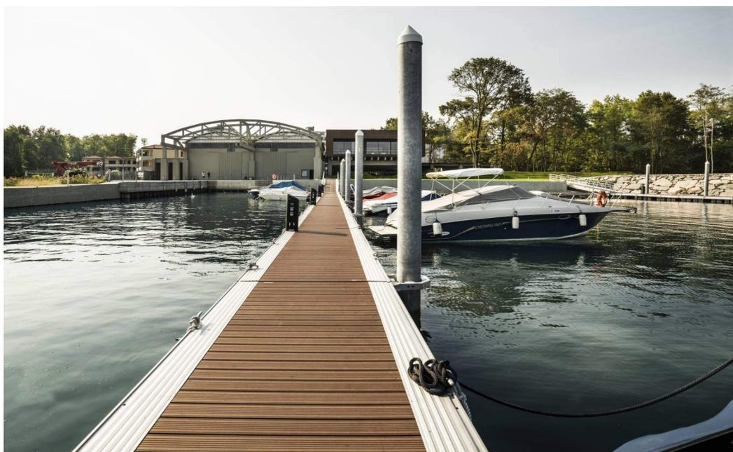
*Figura 8: Pontile con pali di ormeggio - stato post operam (il pontile in cemento è stato sostituito da un pontile galleggiante)*
