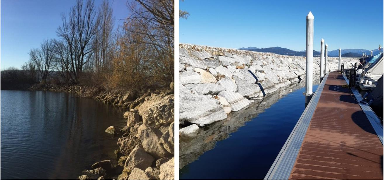
*Figura 12: massi utilizzati per la scogliera (a sinistra stato ante operam - a destra stato post-operam)*
