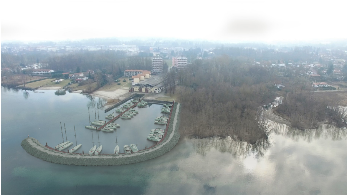
Figura 3: Foto aerea della darsena esistente vista da nord
