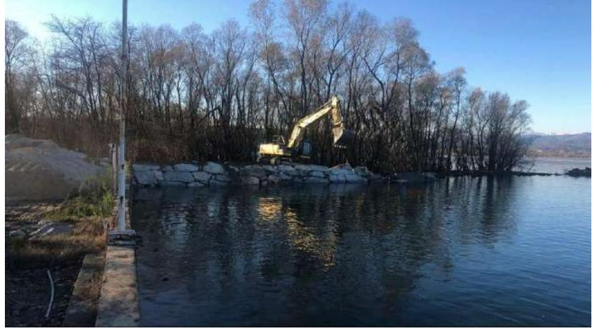
*Figura 44: fasi di lavorazione per il consolidamento e l'innalzamento della scogliera*
