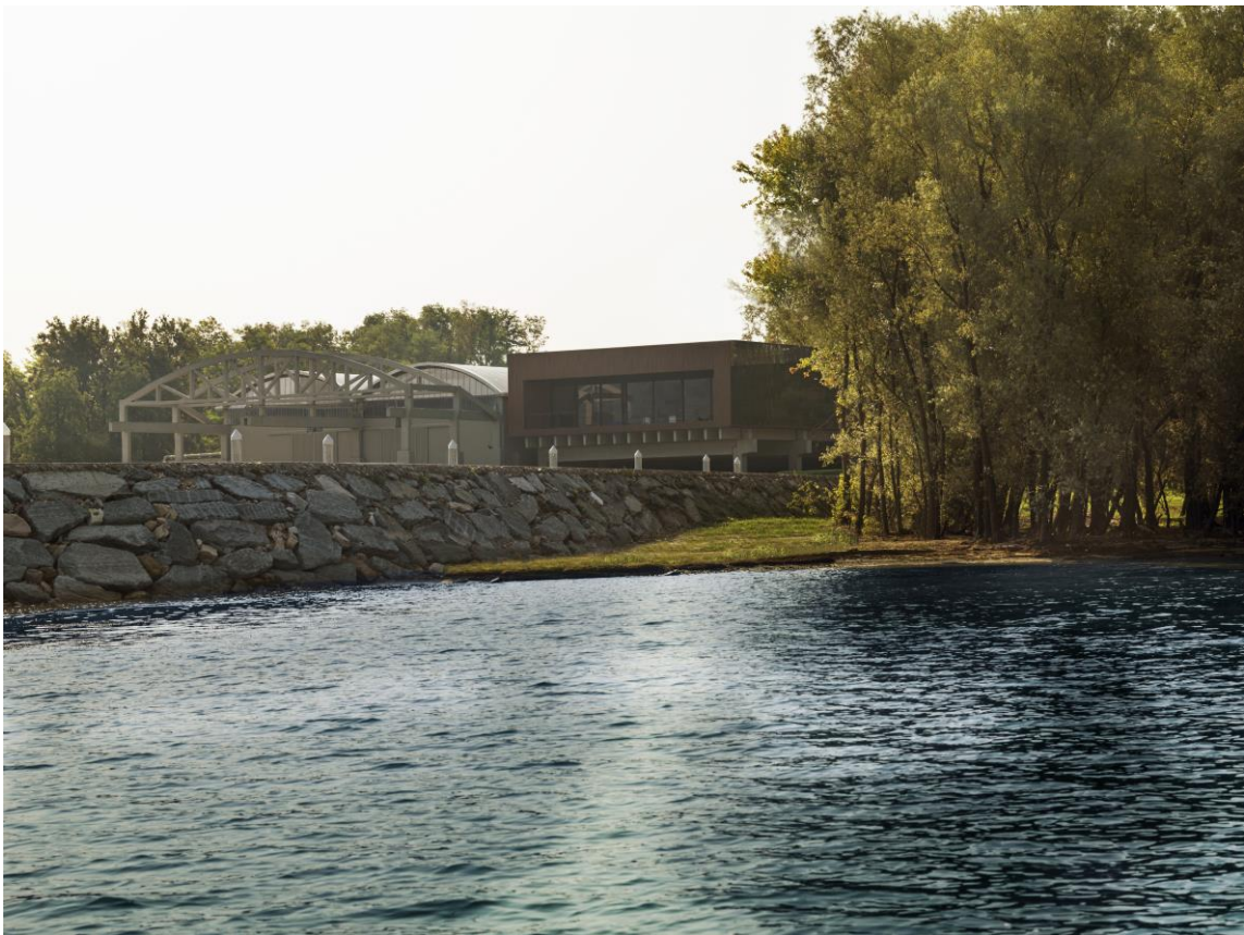
Vista dello stato di fatto della scogliera
