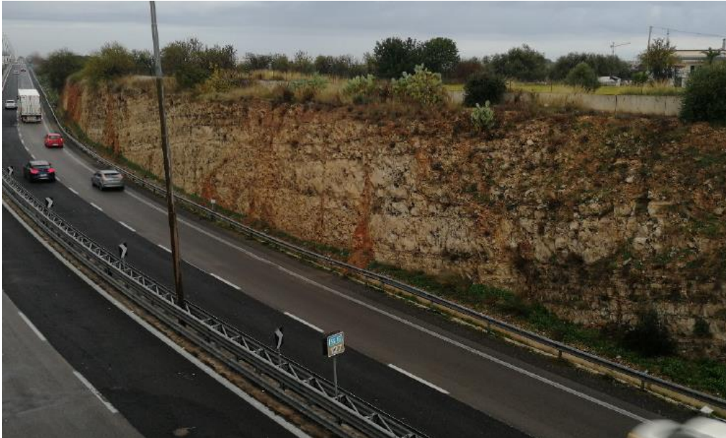
Figura 9-2: calcari della trincea stradale della SS16.
