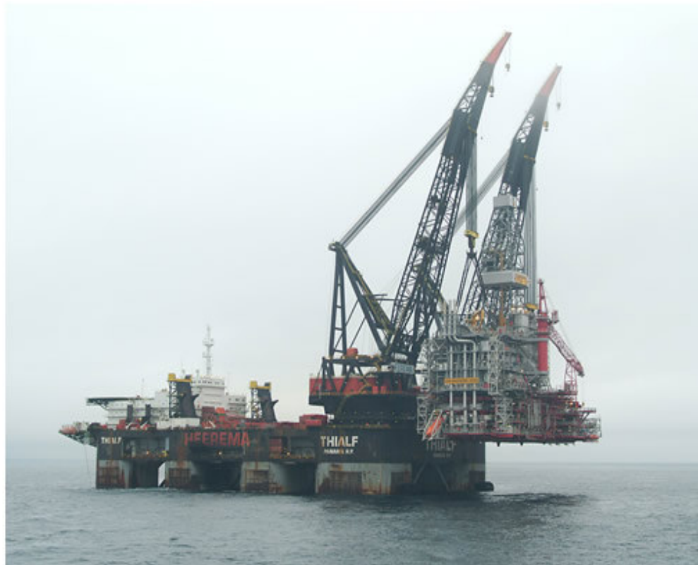
Figura 2.2 – esempio di pontone impiegato per l'installazione di una ESP offshore
