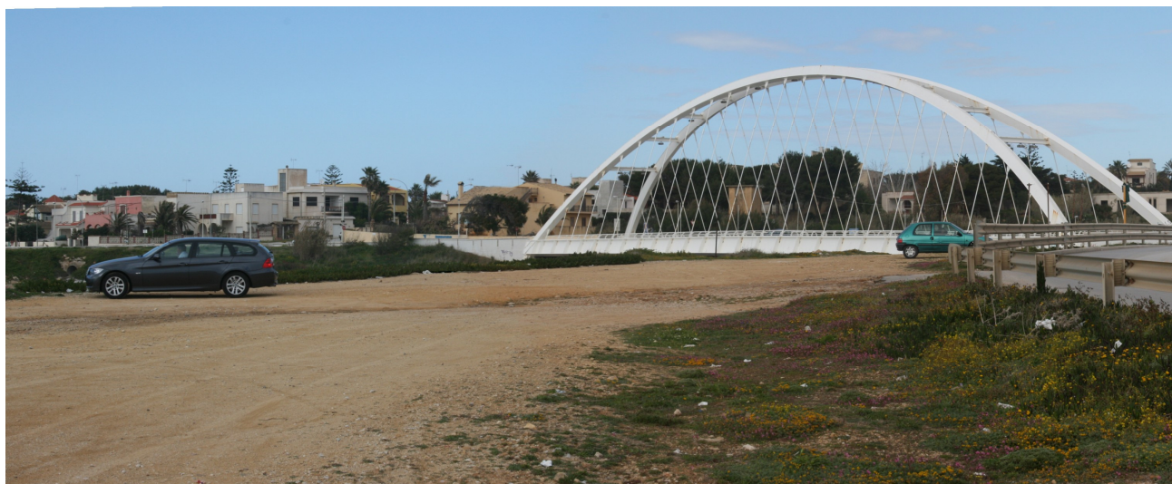
Figura 2-27 Punto di approdo del cavidotto marino, in località “La Bocca”, Mazara del Vallo (TP)
