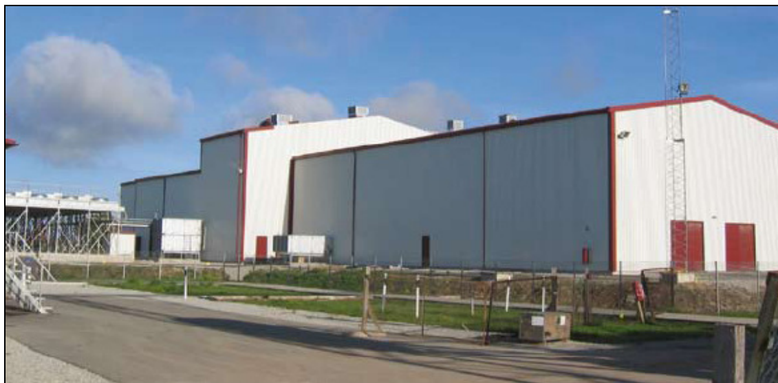
Figura 2-34 ESP ABB HVDC Light da 350 MVA installata ad Harku, Estonia
