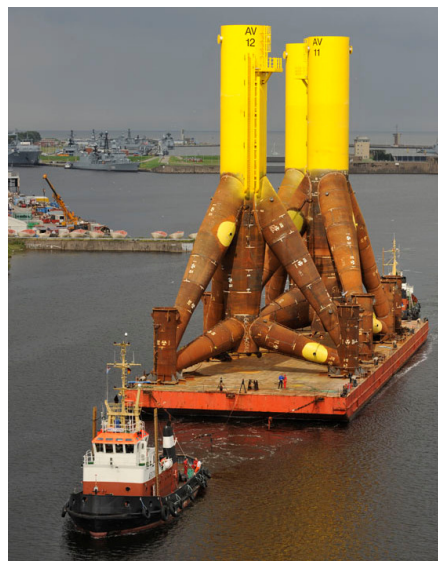
Figura 2-9 trasporto di 2 fondazioni a tripode tramite chiatte e rimorchiatore [ http://www.alpha-ventus.de ]
