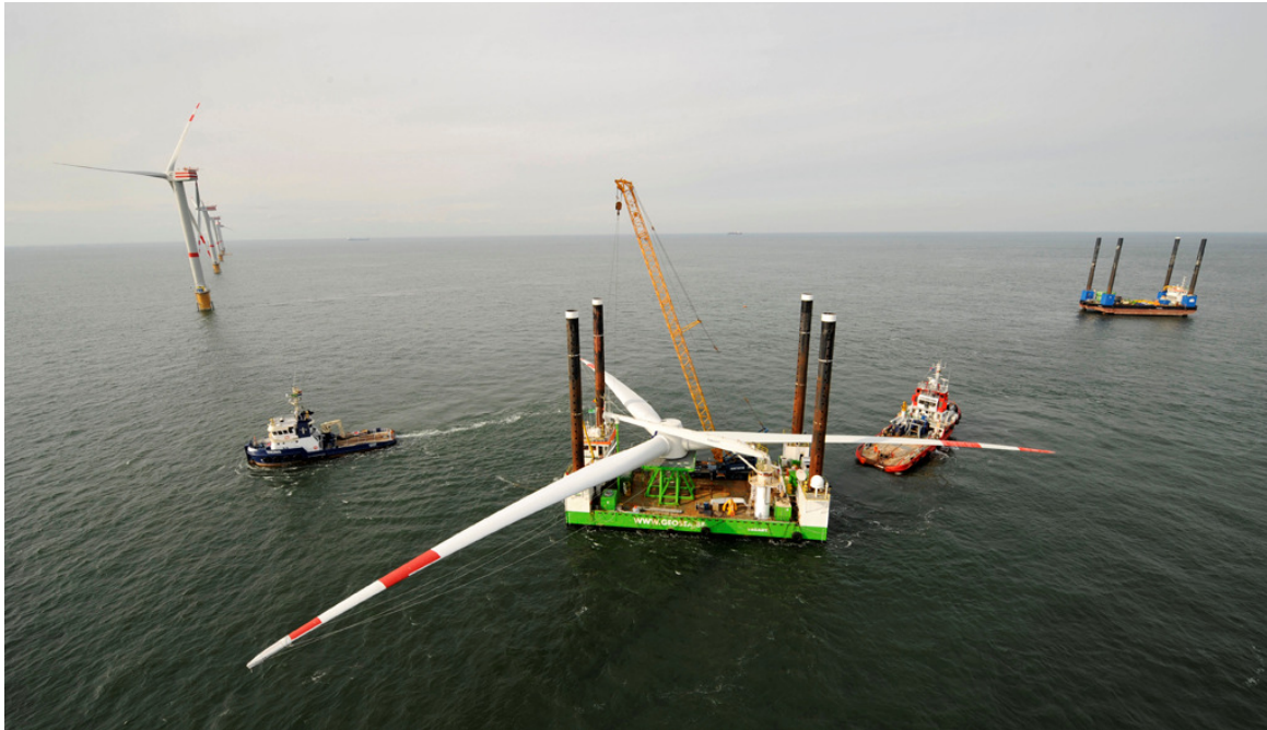
Figura 2-5 Trasporto di rotore assemblato (D = 126 m) tramite chiatta - Thorntonbank wind farm [http://www.repower.de]
