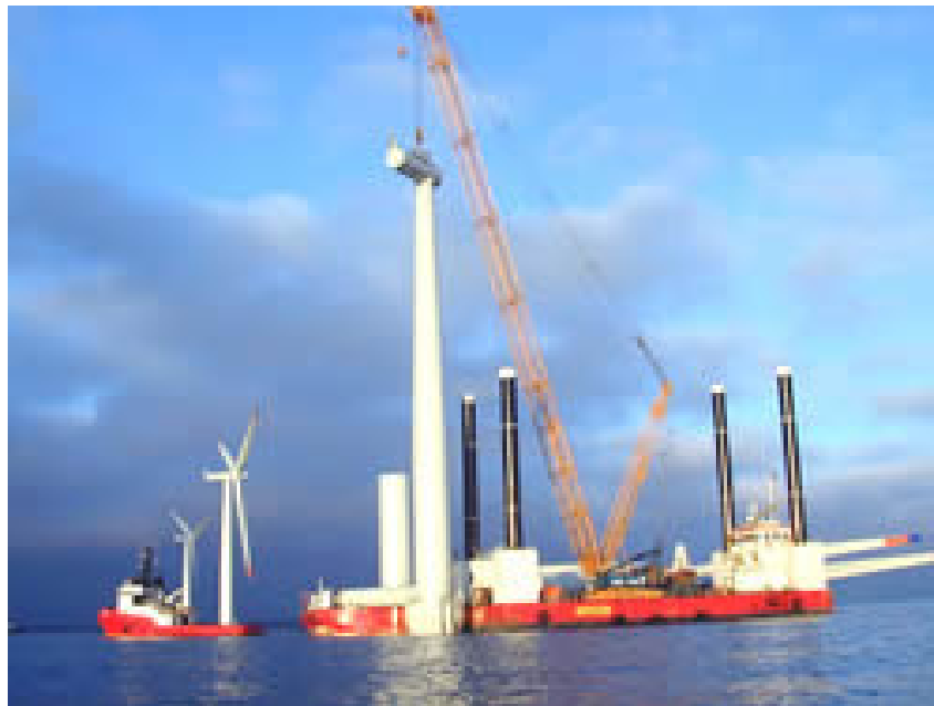
Figura 2-4 Pontone durante l'assemblaggio di una navicella – http://www.c-power.be
