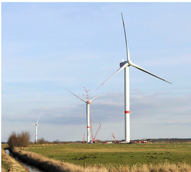
Figura 2-1 Westre wind farm (confine tra Germania e Danimarca – marzo 2009) - 3 aerogeneratori REpower 6M in fase di test
