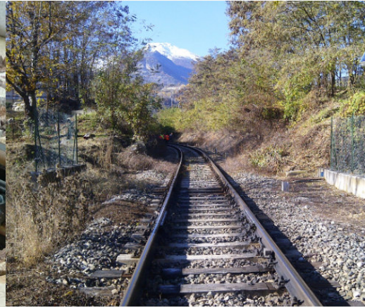
Impianto lubrificazione P.A.L. Italia (Foto: P.A.L. Italia; 2012)
