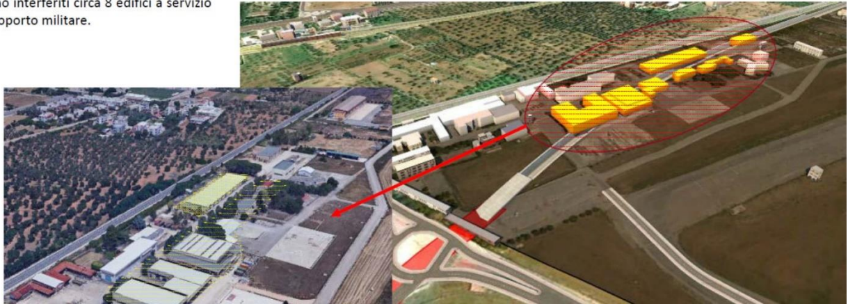
Figura 7-5 Manufatti a servizio dell'Aeroporto militare oggetto di demolizione
