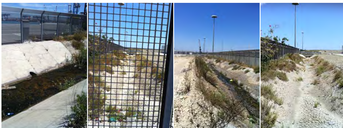
Figura 6. Canale di scolo esistente
