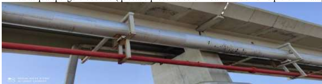
Figura 31 Linea Carbone Pipeline dismessa di trasporto OCD e linea antincendio
