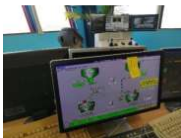
Figura 36 sinottico di controllo del trasferimento ceneri leggere a silos di stoccaggio
