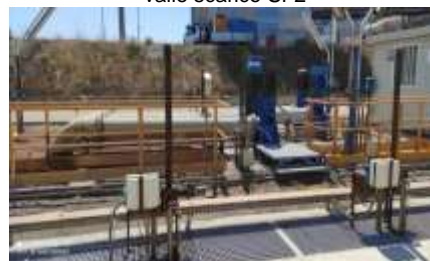
Figura 49 Cabina e impianto di monitoraggio TOC a valle scarico SF2
