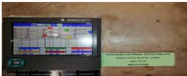
Figura 47 Cabina analisi vasca finale acque reflue: schermata misure parametri chimico - fisici
