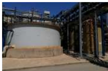
Figura 44 impianto trattamento acque spurghi deSOx, particolare della sezione di riduzione del boro
