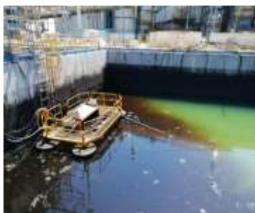
Figura 46 Dettaglio impianto di trattamento acque oleose
