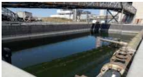
Figura 34 vasca raccolta acque carbonile
