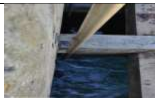
Figura 53 punto di campionamento tubo in Acciaio Inox all'interno del quale passa il tubo per il prelievo del TOC a monte scarico SF2, tale tubo in acciaio è utilizzato anche per calare il tubicino di prelievo dello scarico SF2.
