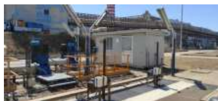
Figura 48 Cabina e impianto di monitoraggio TOC a valle scarico SF2
