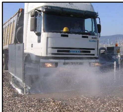
Figura 2: Esempio di mezzi utilizzati in cantiere per abbattimento delle emissioni di polvere
