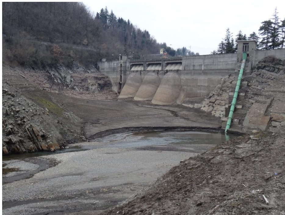
Figura 1 – Stato dei luoghi a monte della diga (foto scatta l'11 marzo 2021)
