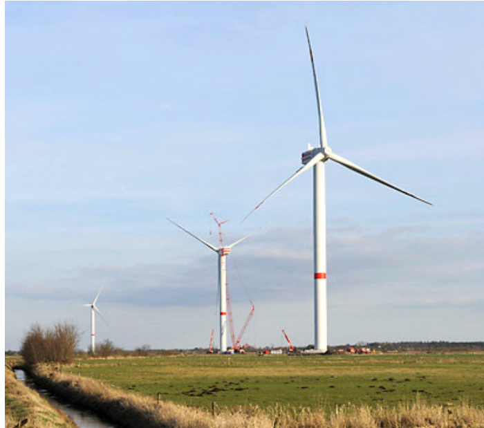
Figura 2-3 Westre wind farm (confine tra Germania e Danimarca – marzo 2009) - 3 aerogeneratori REpower 6M in fase di test
