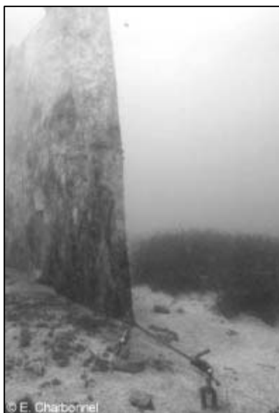
Figura 3-5 Uno schermo in geotessile (a sinistra) che protegge una prateria di Posidonia oceanica (a destra) in un lavoro sottomarino in Francia. (foto E. Charbonnel)
