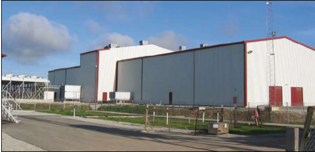
Figura 2-21 ESP ABB HVDC Light da 350 MVA installata ad Harku , Estonia
