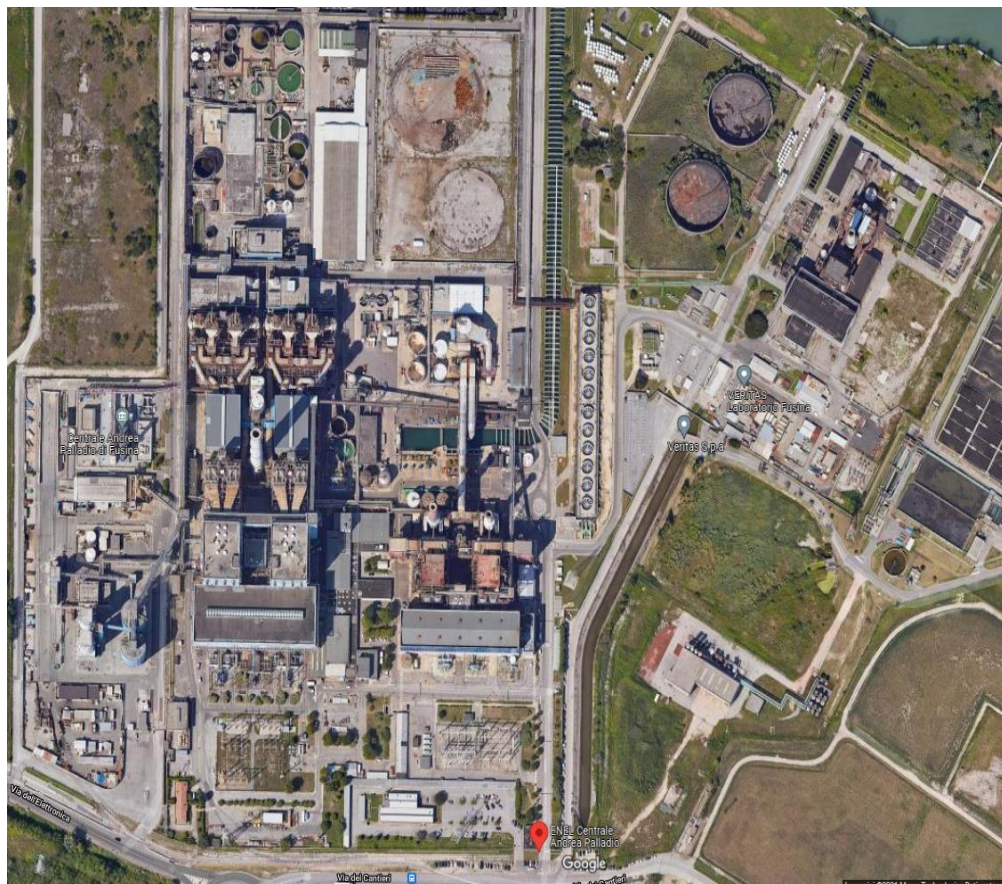
Figura 1 Centrale Termoelettrica "Andrea Palladio" di Fusina (VE).
