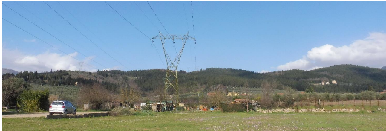
Figura 17: Vista del tratto finale della variante da Via del Colle.
