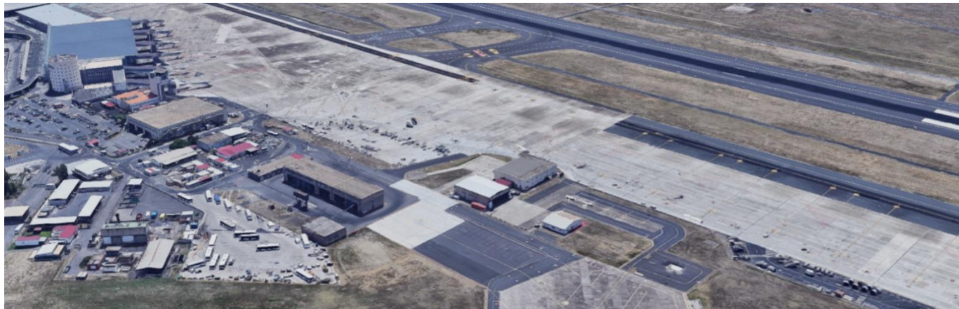
Figura 18-2 Intervento 4A - Apron Ovest: Manufatti edili, piazzali e viabilità presente in corrispondenza dell'area di intervento
