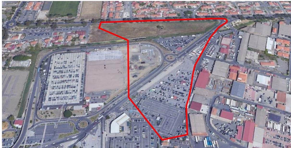
Figura 17-2 Intervento 21 – Polo ambientale: Area di localizzazione allo stato attuale
