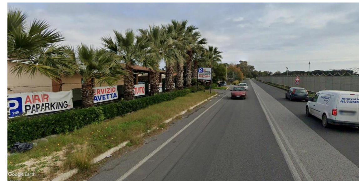
Figura 2-10 Tessuto strutturato lungo Via San Giuseppe alla Rena - Consistenza del tessuto edilizio e dell'assetto funzionale: Assenza di funzioni residenziali
